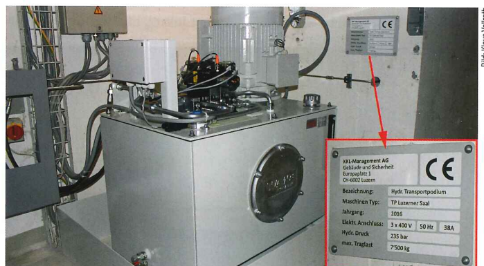
Die kompakte Hydraulikeinheit aus Pumpe, Behälter, Steuerventilen, Sensorik und interner Verkabelung wurde komplett montiert und getestet angeliefert und musste nur noch angeschlossen werden. Das Typenschild mit CE-Kennzeichnung weist das KKL als Hersteller aus.
